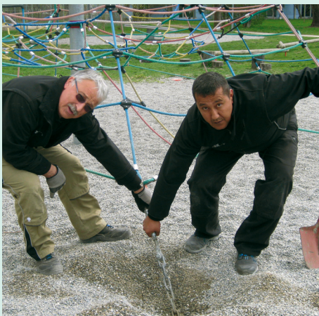
Ist die Verankerung des Kletternetzes noch stabil?
