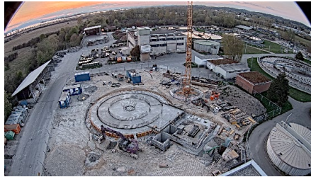
Betonierung der Bodenplatte, 20. April 2021
