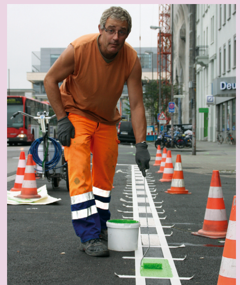
Sorgfältig ausgeführte Markierungsarbeiten.
