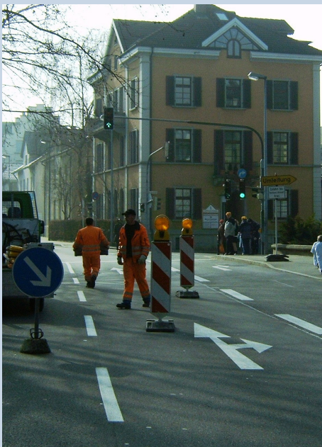
Verkehrsführung hat Gewicht: 28 kg pro Bodenplatte.
