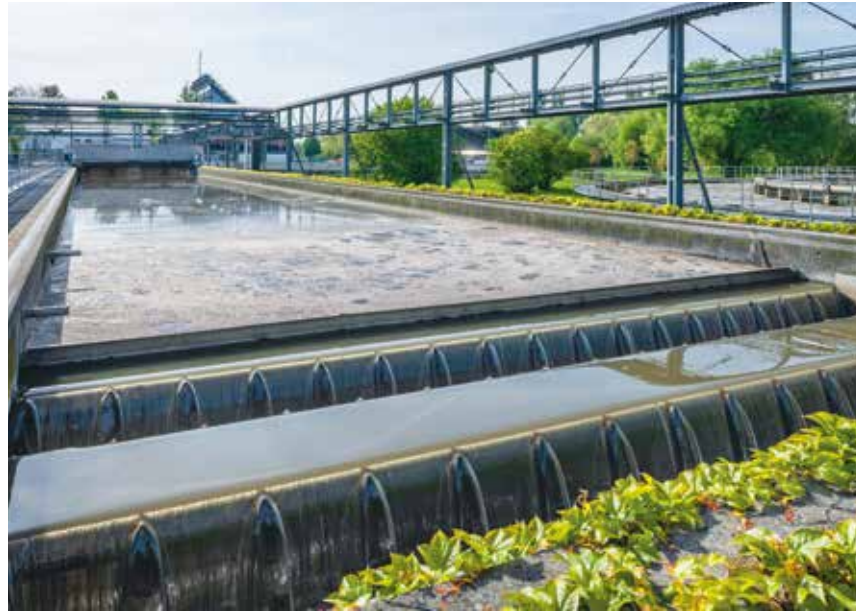
Die Konstanzer Kläranlage reinigt bis zu 40 Millionen Liter Abwasser – täglich!
