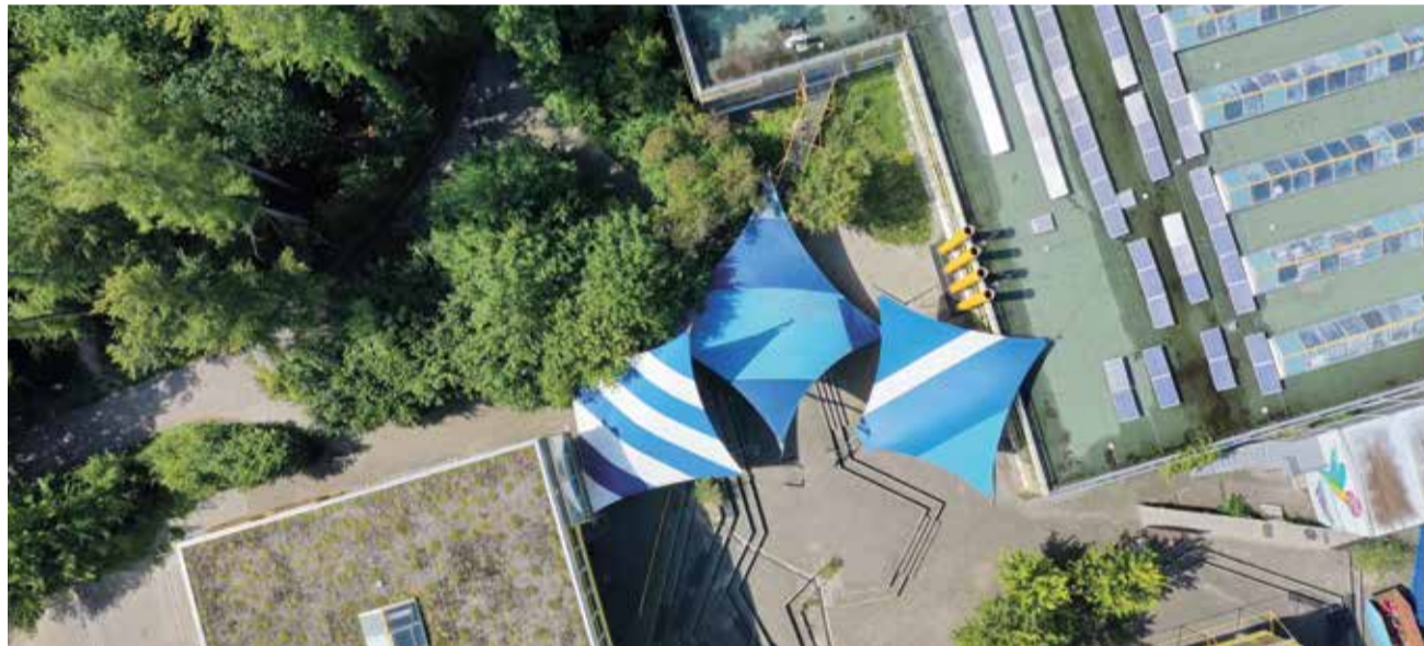
Die Sanierung des Flachdaches gehört zu den Schwerpunkten der Maßnahmen in der Geschwister-Scholl-Schule.
